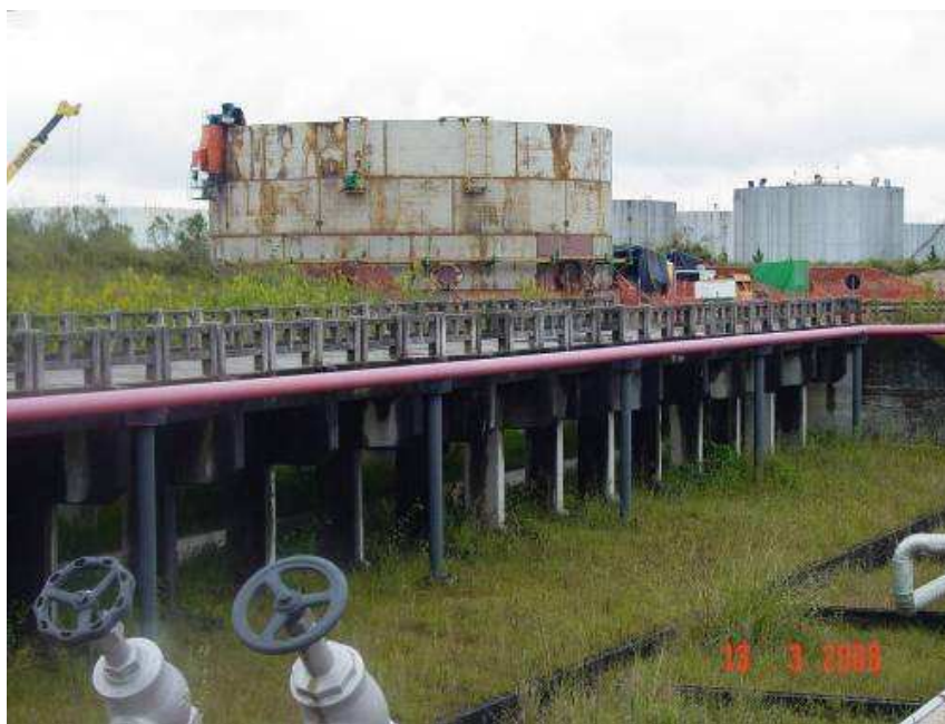
Figura 3 – Foto do pontilhão P-M4 na REPAR.
